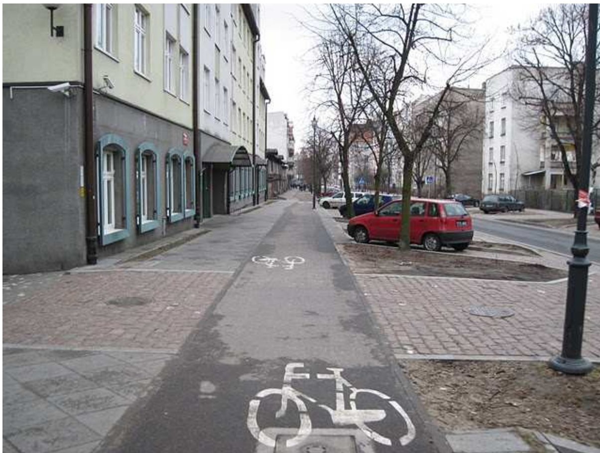
Rysunek 3. Inny przykład prawidłowo zaprojektowanego zjazdu na przecięciu DDR – konieczne zachowanie niwelety DDR i nawierzchni DDR
