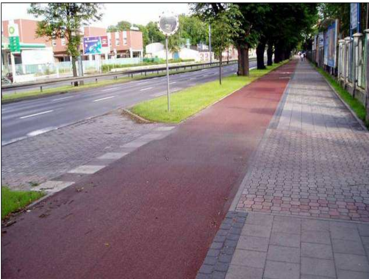
Rysunek 2. Prawidłowo zaprojektowany zjazd na przecięciu DDR – konieczne zachowanie niwelety DDR i nawierzchni DDR
