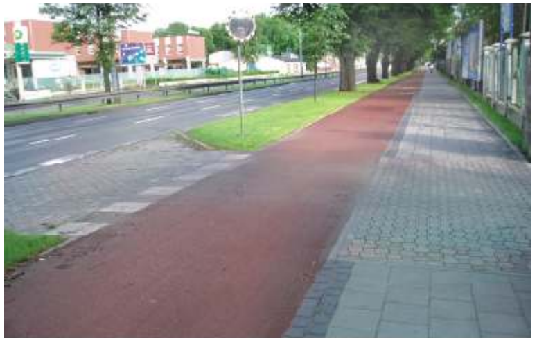
DOBRCZE: Droga rowerowa z ciągłą nawierzchnią na wyjazdach z posesji (Gdańsk, ul. Grunwaldzka).
