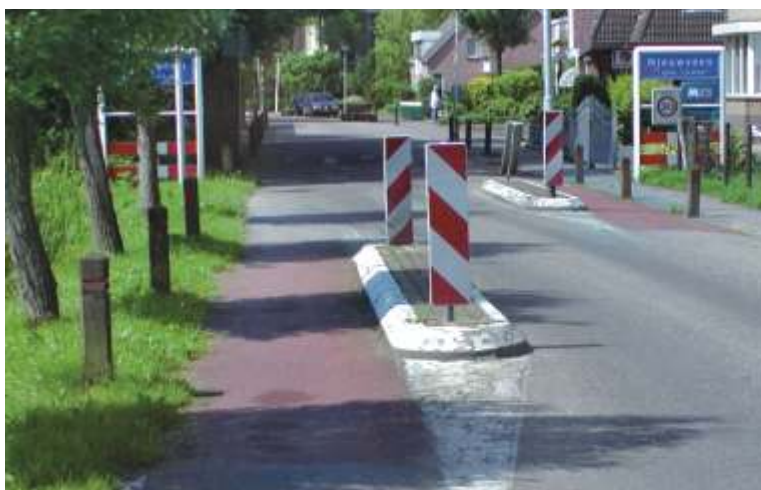
DOBRE: uspokojenie ruchu poprzez zwężenie jezdni z pozostawieniem przepustów dla rowerów (Nieuwveen, Holandia).
