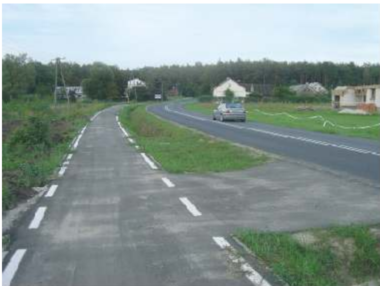
DOBRE: asfaltobeton rozścielany maszynowo (Gostynin, droga do Lucienia).
